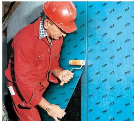
PCI Pecithene do uszczelniania zewnętrznych ścian piwnic także przy niskich temperaturach otoczenia do -5 °C.
