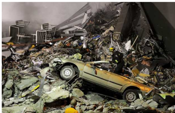
Przykład zniszczonego budynku
